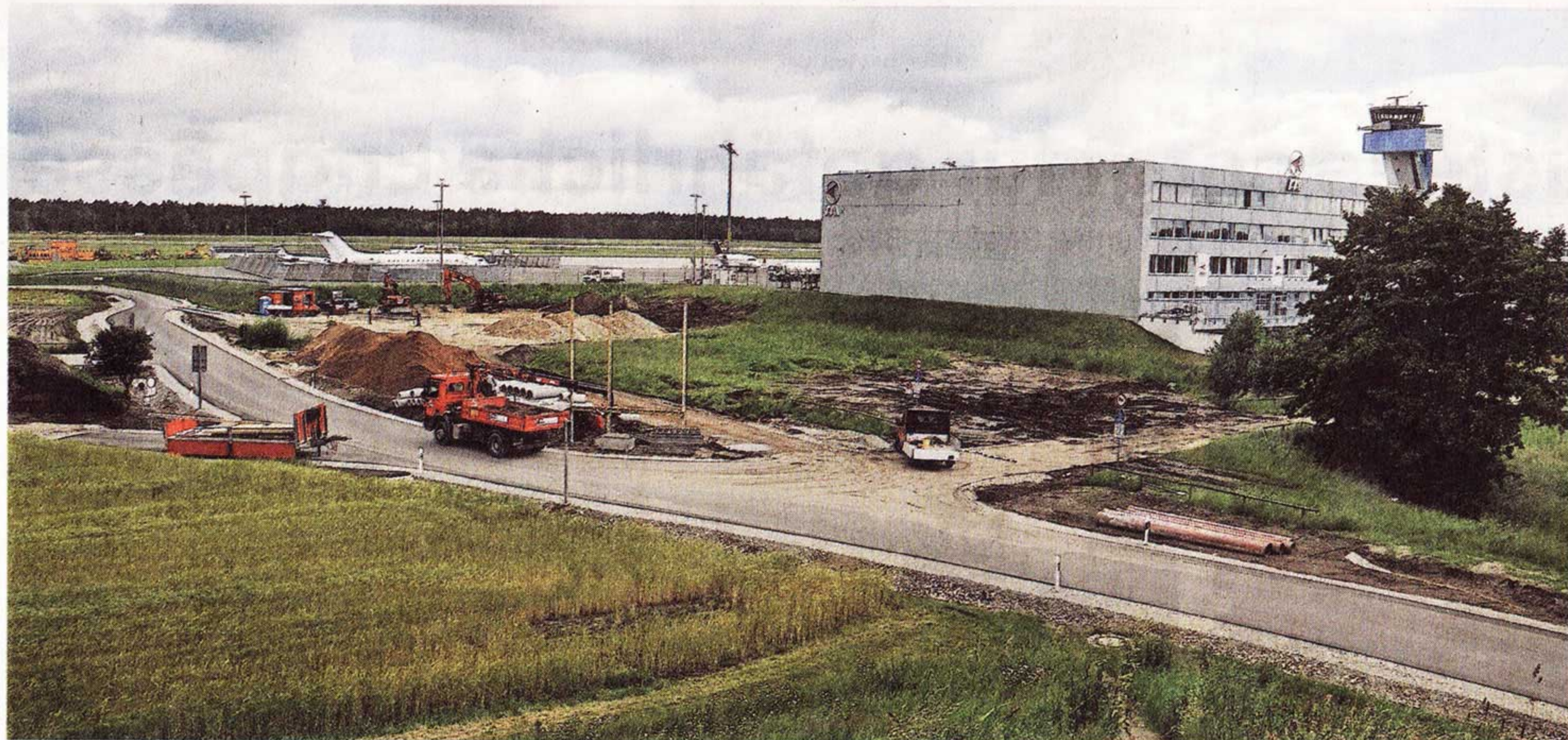
Ein paar Meter verschoben wurde jüngst die Irrhainstraße am Westrand des Flughafens, weil hier eine neue Halle gebaut wird. Beim geplanten Buskonzept 2015 spielt eine mögliche Ersatzroute zwischen B4 und Airport eine wichtige Rolle. Foto: Harald Sippel
